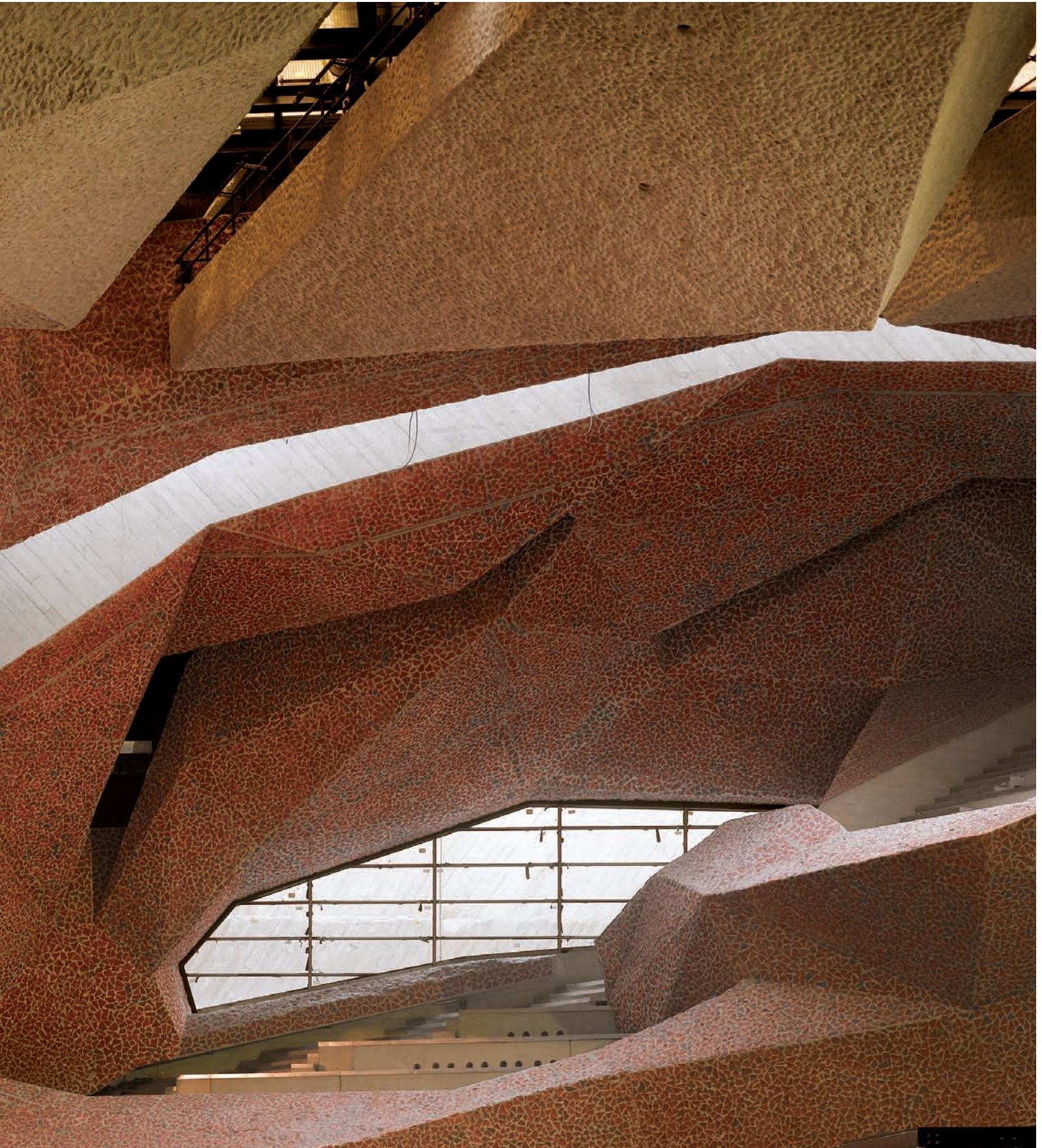
ที่โปแลนด์ หอแสดงคอนเสิร์ตในศูนย์วัฒนธรรมจอร์ดันกี (Jordanki) ที่สร้างโดยสถาปนิก เฟอร์นันโด เมนิส (Fernando Menis) มีรูปฟอร์มที่ดูคล้ายกับเป็นถ้ำ ด้วยด้านมุมที่มืองศาแตกต่างกันที่ออกแบบขึ้นจากการคำนึงถึงการตกกระทบของเสียง.
